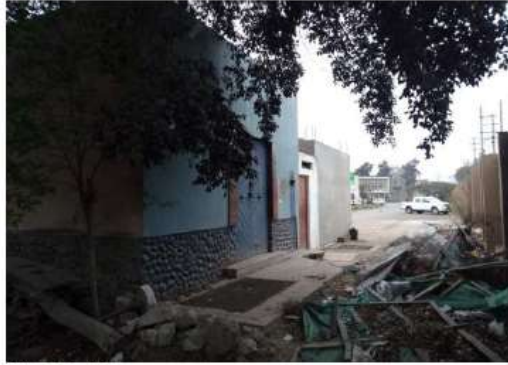
Vista sub estación eléctrica
